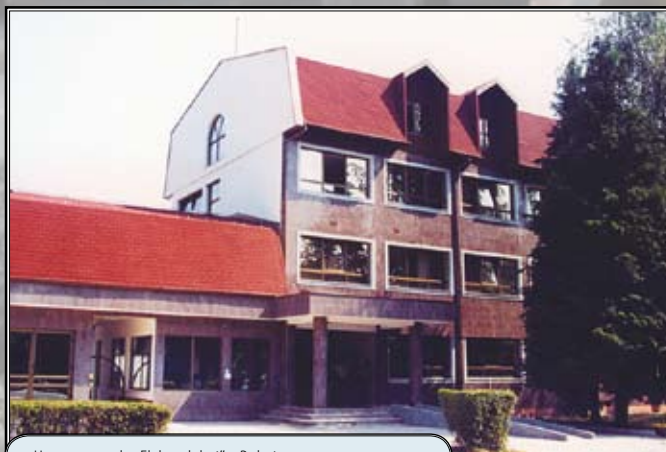
Upravna zgrada „Elektrodoboj” u Doboju
