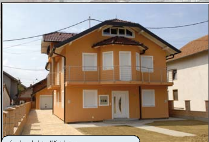
Stambeni objekat sa PVC stolarijom
