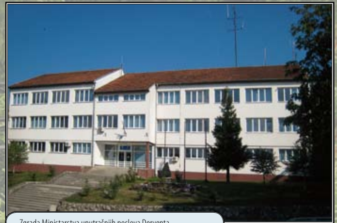
Zgrada Ministarstva unutrašnjih poslova Derventa
