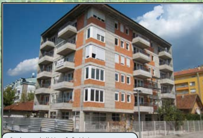
Stambena zgrada „Uni-invest“ u Banjaluci
