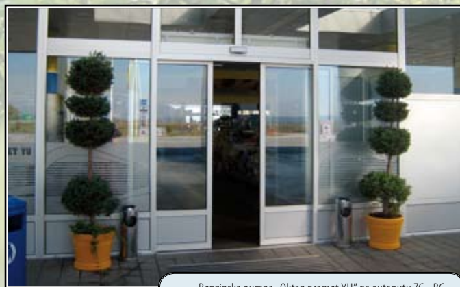
Benzinska pumpa „Oktan promet YU“ na autoputu ZG - BG
